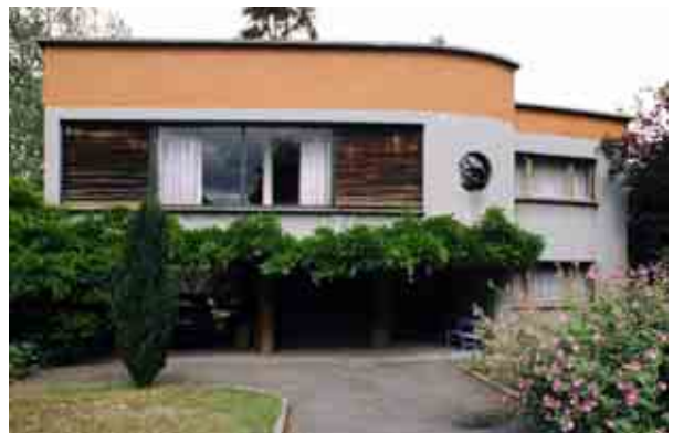
Deux exemples remarquables de villas modernes. En haut, la villa Reverdin à Cologny En bas, la villa Vincent à Thônex photos SMS / M. Jaquet
