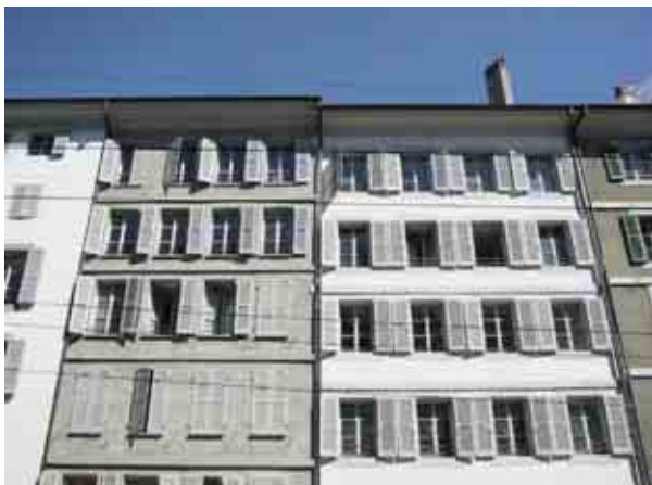
Sur la rue de Coutance les opérations doivent se fonder sans signes distinctifs, alors que dans la rue des Etuves, l'ancienne boucherie demandait une recomposition en finesse. photos SMS / J-P Lewerer
