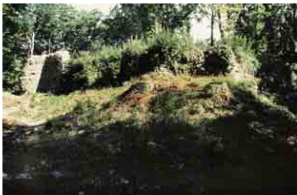
Travaux de dégagement, de restauration et de mise en valeur des ruines du château de Rouelbeau. photos Service d'archéologie / J.Terrier
