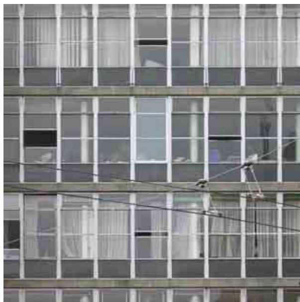
Détail de la façade de Mont-Blanc Centre, avant et après l'opération de remplacement à l'identique photos DeLaMa
