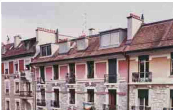
A quelques pas de la place Claparède, à l'angle de la rue Sautter, n° 29. Quand et comment faut-il favoriser des lucarnes groupées pour augmenter la lumière tout en s'accordant avec l'esthétique très classique d'Alfred Olivet et parfois, comme à la rue Bergalonne jouer avec les massifs de cheminées. photos: I. Claden (haut), SMS / J-P Balmer (bas)
