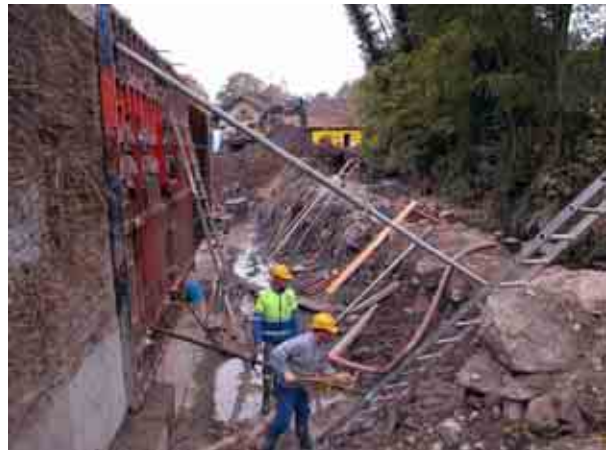
En haut, la mise en place du coffrage avec roseaux.
