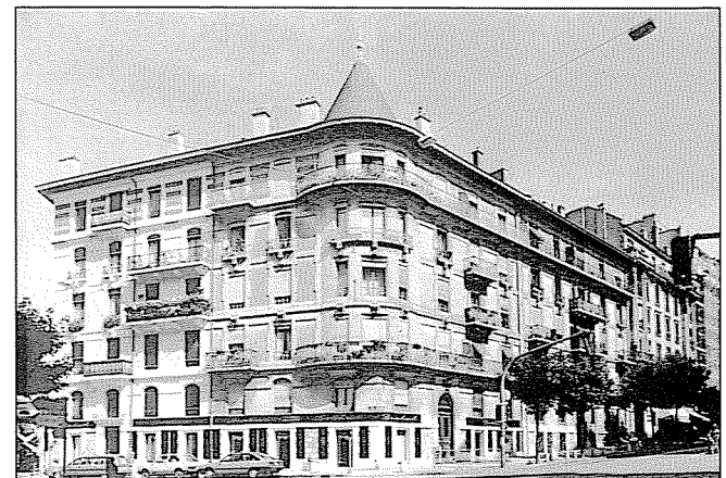
Rue du 31-Décembre 65, avenue Pictet-de-Rochemont 25-29
