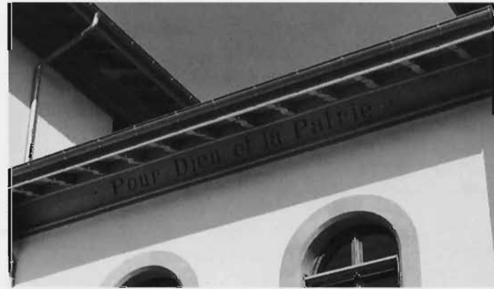
▼ ► Emplacements des maximes sous les toitures
