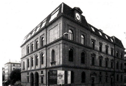
Le Grütli: vue extérieure, état actuel Le Grütli: Aussenansicht, heutiger Zustand
